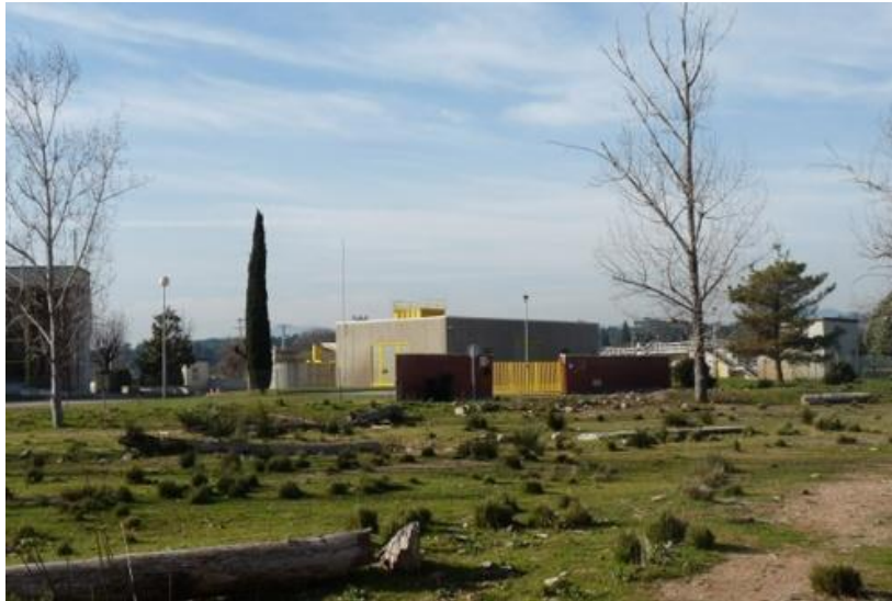
EDAR de La Garriga (Barcelona)
