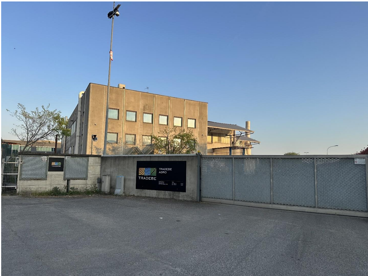
IMPIANTO DI TRATTAMENTO E SMALTIMENTO DI RIFIUTI LIQUIDI
