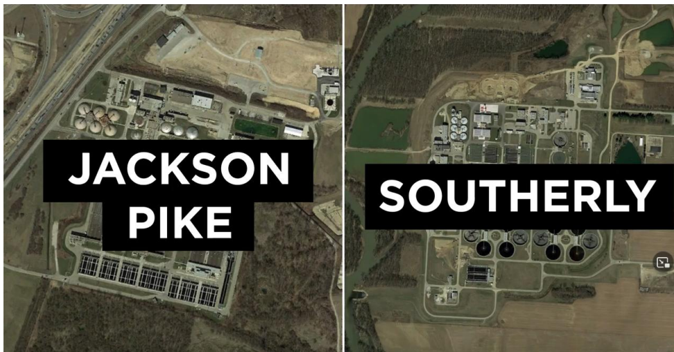
Plantas de Tratamiento de Aguas Residuales de Jackson Pike y Southerly en Columbus
