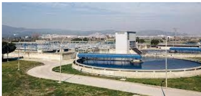
WWTP Gavà - Viladecans
