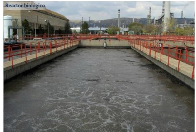
Uno de los canales del reactor biológico
